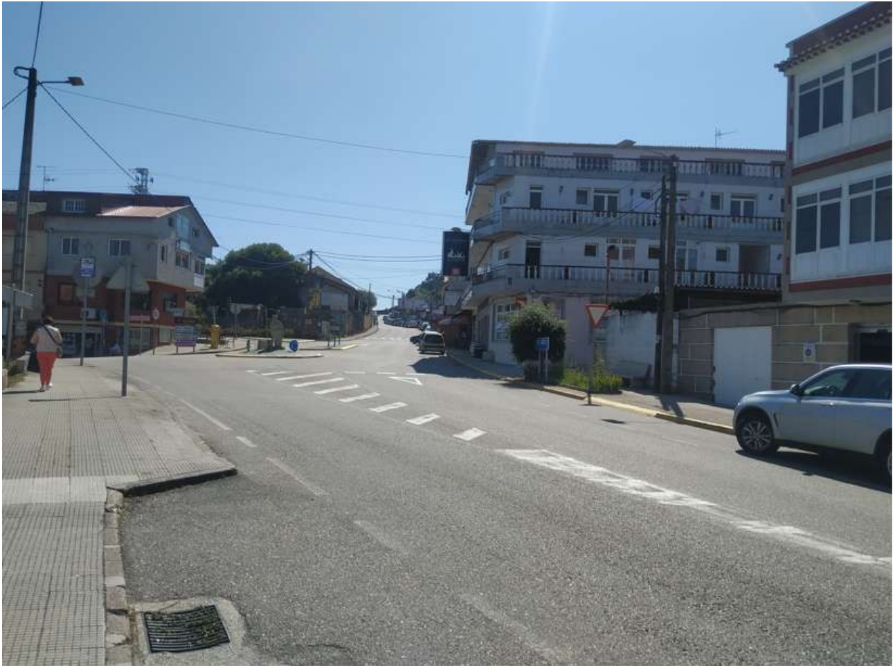
Avenida de Peinador, en la parte final
