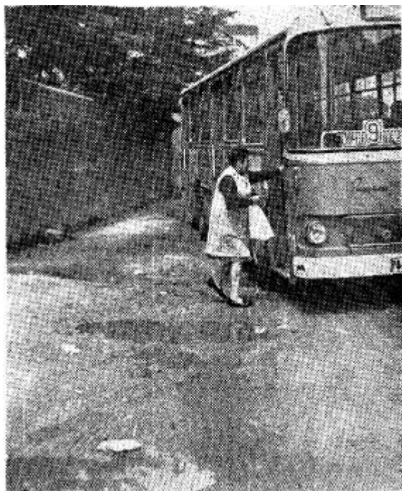
El Vitrasa se ampliaría a Chapela para sustituir el servicio de los tranvías a la Avenida del Generalísimo (actual Avenida de Vigo), en la foto, realizada en 1974, vemos el estado de la avenida en aquellos años. Imagen: Faro de Vigo, 31 de mayo de 1974, p.16
