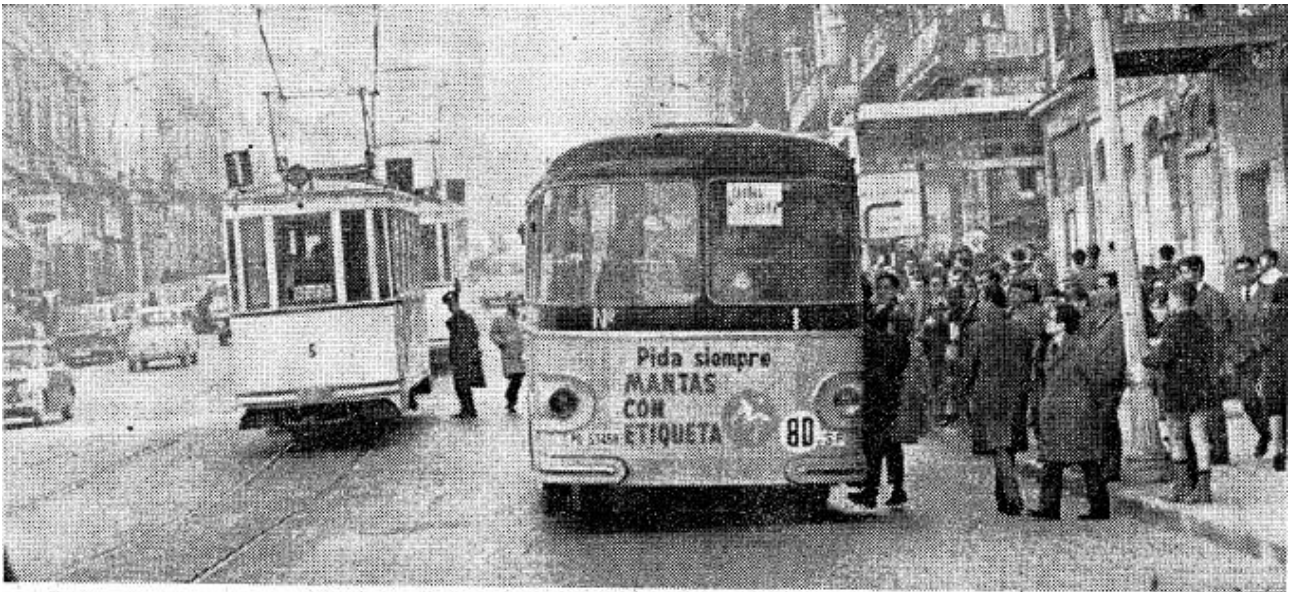
Tranvías y autobuses juntos...sucedó ya en 1967, por avería de un transformador. Imagen: Faro de Vigo, 18 de diciembre de 1967, p.12
