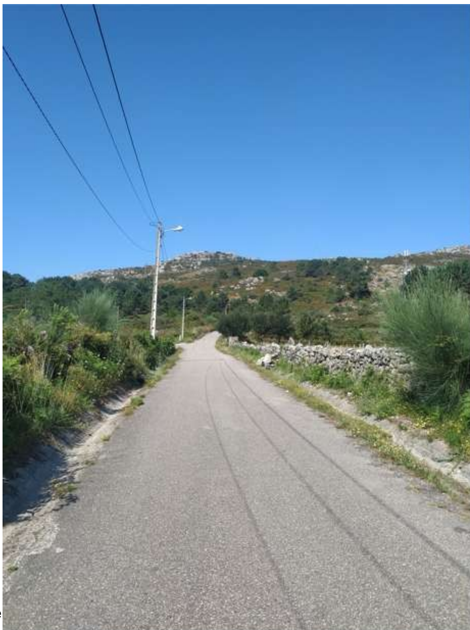
Estrada de Cabo Silleiro
