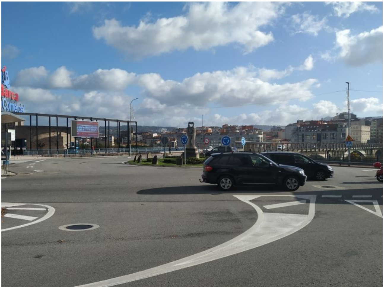
Rotonda da Barca, con el puente que separa Poio de Pontevedra.
